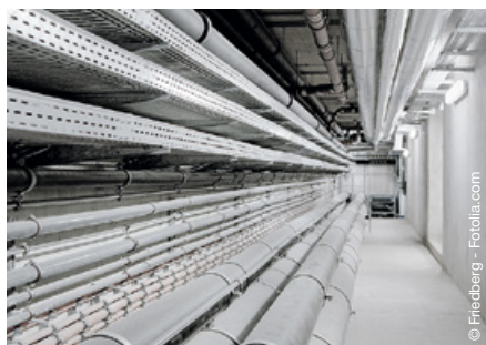
Fixation de conduits de câbles
