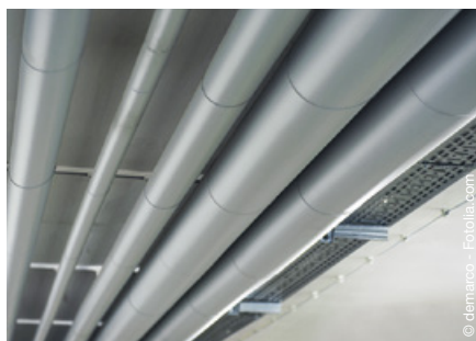
Montage de tubes
