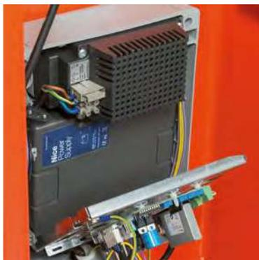
**Entretien facile** - centrale intégrée, pouvant être extraite pour faciliter le câblage et l'entretien. Aucune panne de courant grâce à la batterie tampon pouvant être intégrée dans la centrale.
