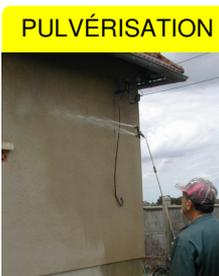
**N.B.:** Il est possible d'ajouter au produit une fonction fongicide en incorporant l'adjuvant fongicide (réf. 791 250), ou une fonction insecticide en incorporant l'adjuvant insecticide (réf. 793 250).
