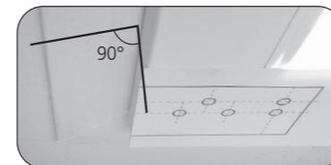
Placer le gabarit «**Partie 1**», à l'aide d'une équerre de telle façon que son bord se trouve dans l'alignement du battant. **Le bord du gabarit peut dépasser dans le cas d'une fenêtre biseautée.**
