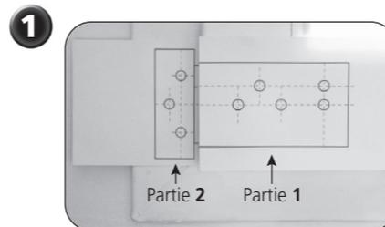
Placer et fixer à l'aide d'adhésifs le gabarit de pose sur l'angle inférieur **droit** ou **gauche** du vantail selon le sens d'ouverture de la fenêtre.
