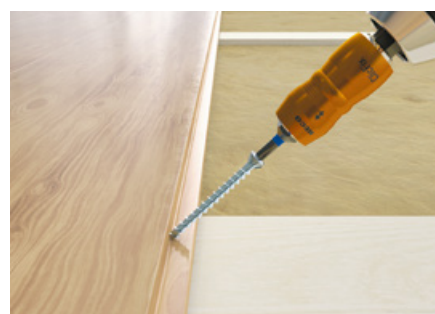
Fixation de revêtements de plancher
