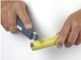
Dénuder le FLEXIPIPE à l'aide d'un cutter
