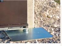
Il vaut mieux y penser avant ! L'installation du Frog est simple mais nécessite la pré-installation la caisse de fondation.
