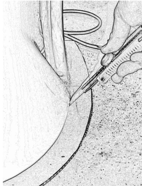
3/ Découper le surplus du support à l'aide d'un cutter en respectant un angle de 45° (suivant schéma)
