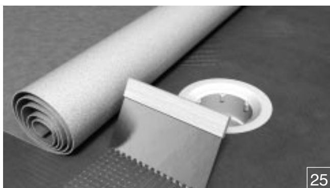
Mise en place du revêtement de sol plastique.
