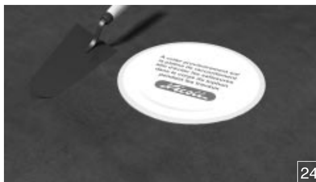
Coller le film protecteur sur le corps du siphon. Réaliser une chape, puis lisser jusqu'au niveau de la platine.
