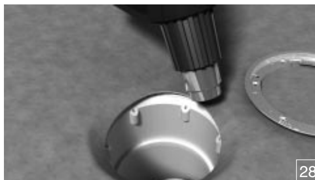
Chauffer le revêtement à la périphérie du trou.*
