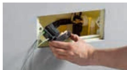
1 Le mécanisme est remplacé par l'unité à câble avec le servomoteur
