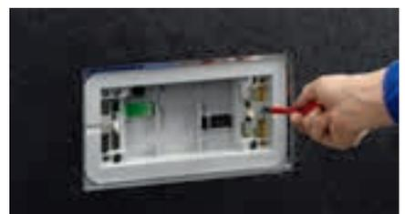
4 La plaque de montage est fixée au réservoir puis la plaque de commande est montée.
