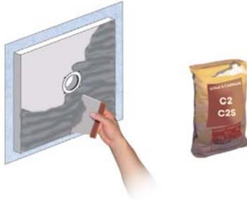
**E** Encoller la face inférieure du panneau PSE Haute Densité à l'aide d'une colle de Type C2 ou C2S.
